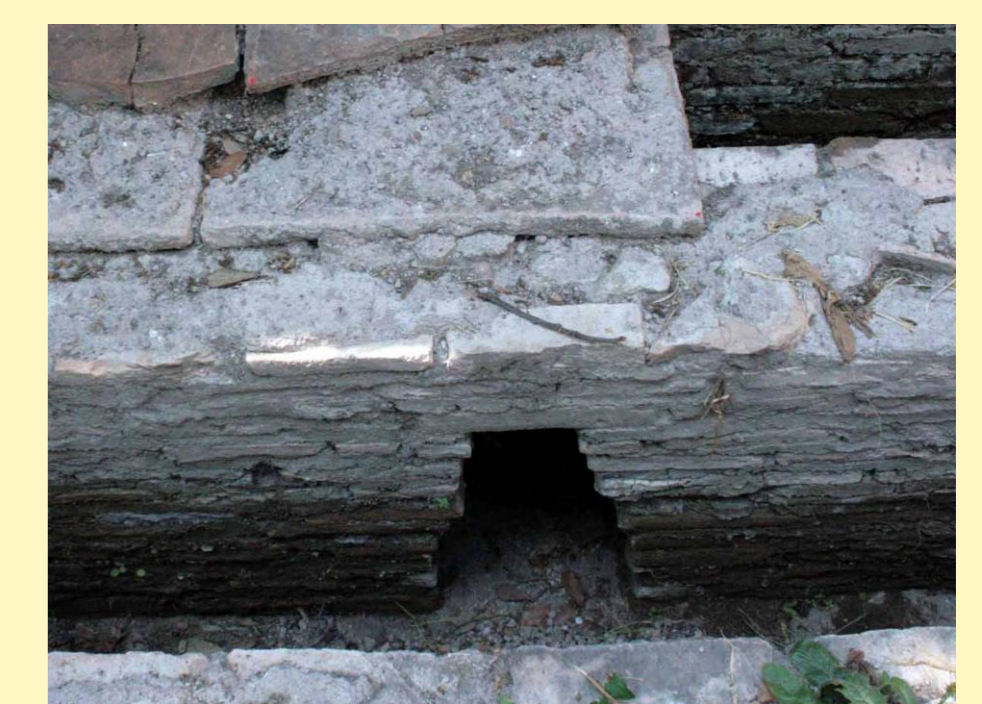
Fig. 12. Foro di aerazione
