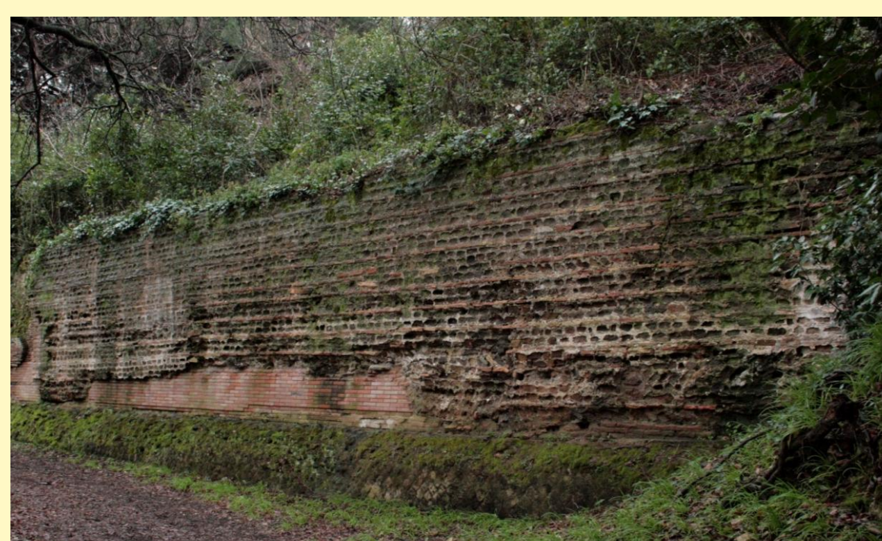
Fig. 13. Muratura in vittata lungo il fronte settentrionale dei Magazzini di Traiano
