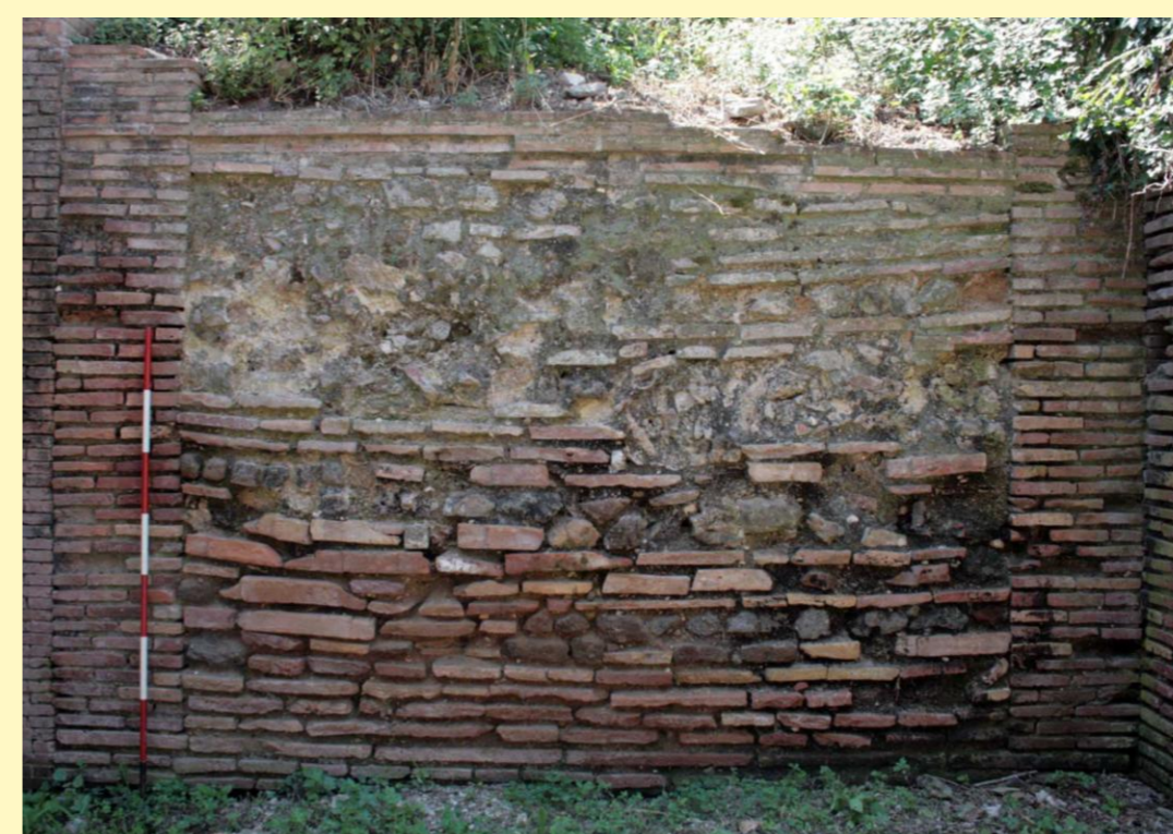
Fig. 9. Tamponatura in opera vittata in prossimità della Strada Colonnata
